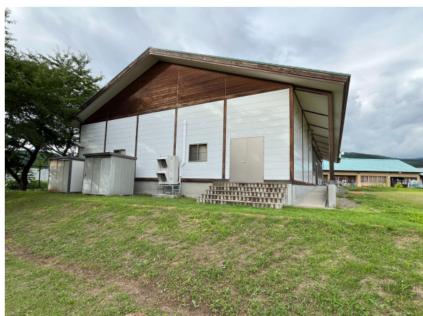
磐梯幼稚園 遊戯室 裏出入口側
